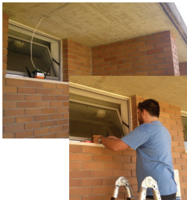
Instalação do equipamento WiFi experimental na piscina-praia de Castelo Branco, em agosto 2016.
