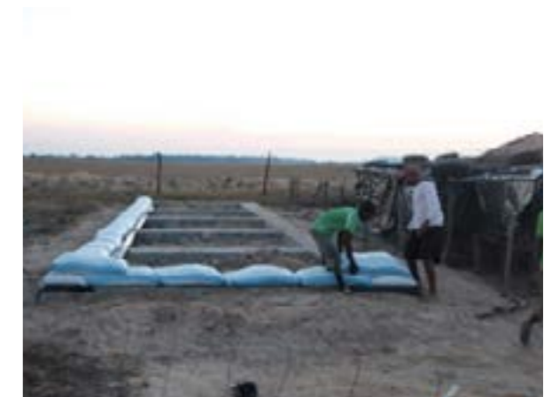
Fig. 6 - Colocação da primeira fiada de sacos.
