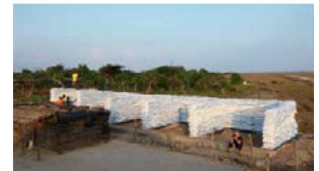
Fig. 7 - Fase final da colocação de sacos.
