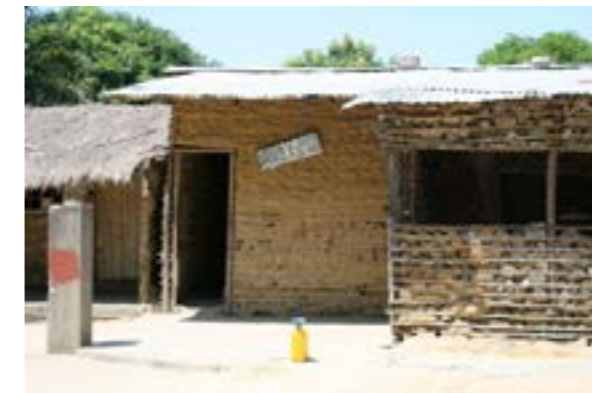
Fig. 2 - Construção de terra de recobrimento na vila do Nhangau, Moçambique.
