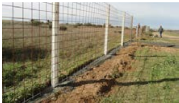
Fig. 2. Cerca fixa chumbada em betão.
