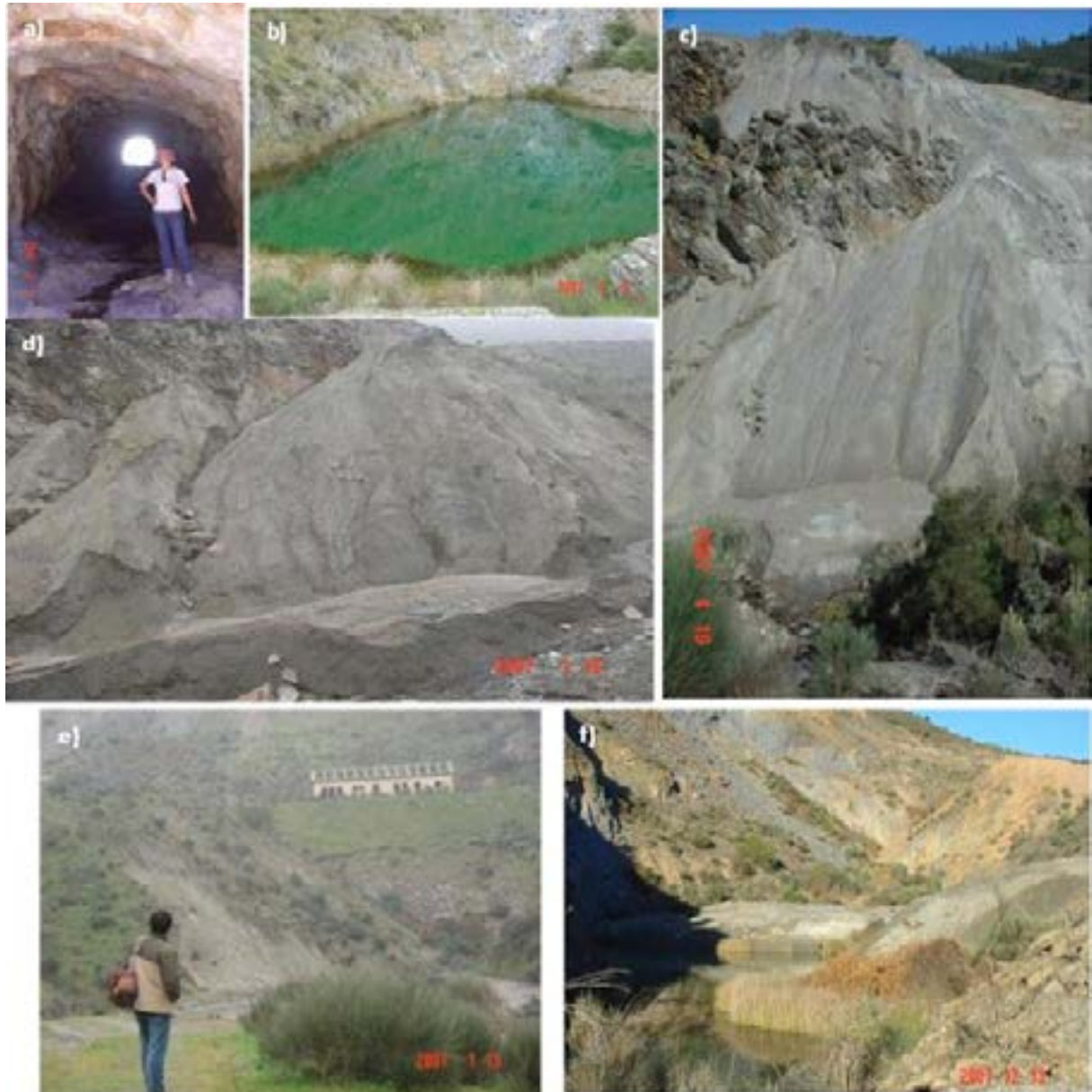
Fig. 2 - Características da área mineira abandonada de Fonte Santa: a) exploração a céu aberto; b) lagoa de mina; c) escombreira de finos; d) ravinação nas escombreiras; e) escombreiras de grosseiros; f) desabamento de inertes, após um período fortemente chuvoso.
